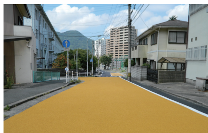
車道部 坂道カーブ カラー舗装(ニート工法)
