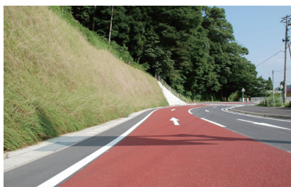
車道部 カーブ カラー舗装(ニート工法)
