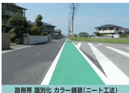
路側帯 識別化 カラー舗装(ニート工法)
