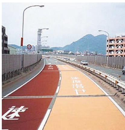
車道部 識別化カラー舗装(ニート工法)
