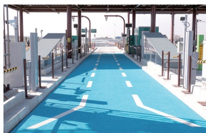
料金所(ETCレーン) 識別化 カラー舗装(ニート工法)
