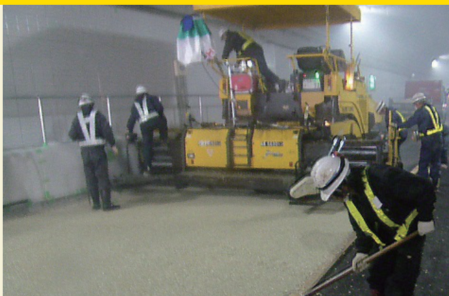
②アスファルトフィニッシャーによる敷均し
