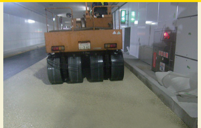
④タイヤローラによる仕上げ転圧
