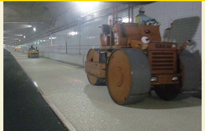
③ロードローラによる転圧
