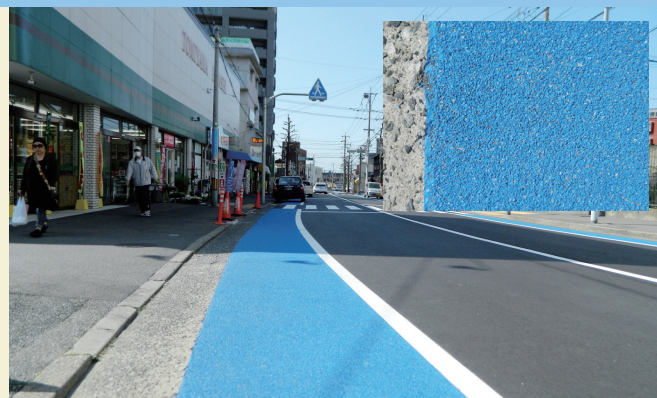
樹脂系すべり止め舗装
