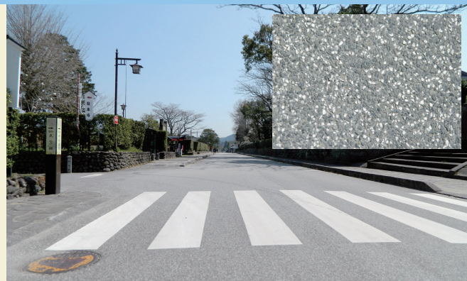
アスファルト舗装
