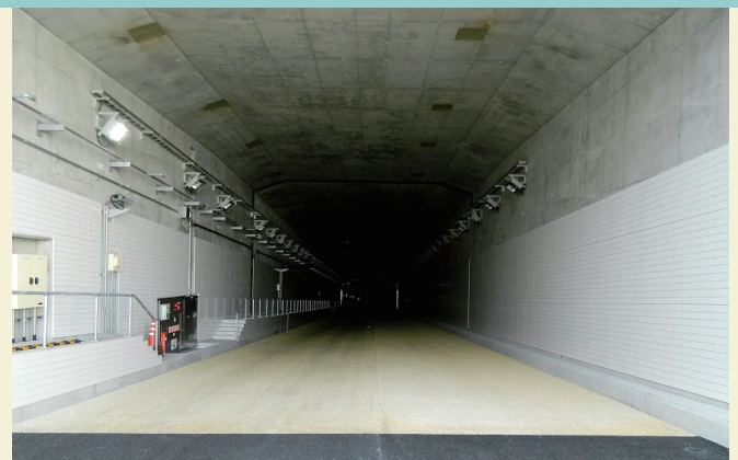
ハイパーセラR 脱色アスファルト舗装
