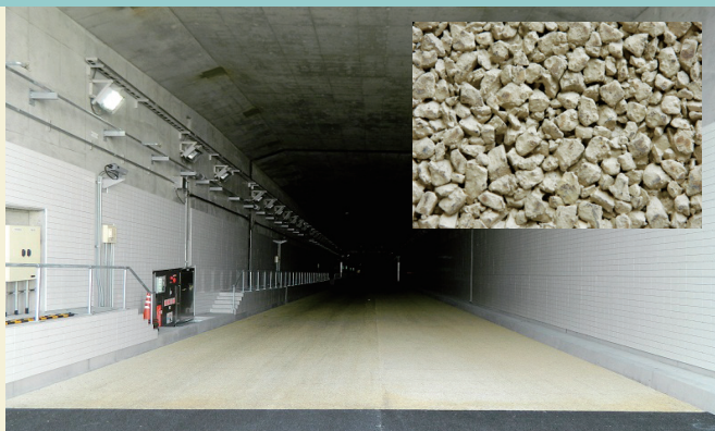
脱色アスファルト舗装
