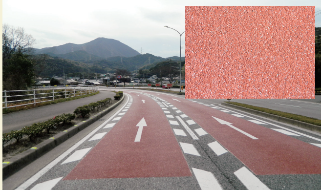
樹脂系すべり止め舗装
