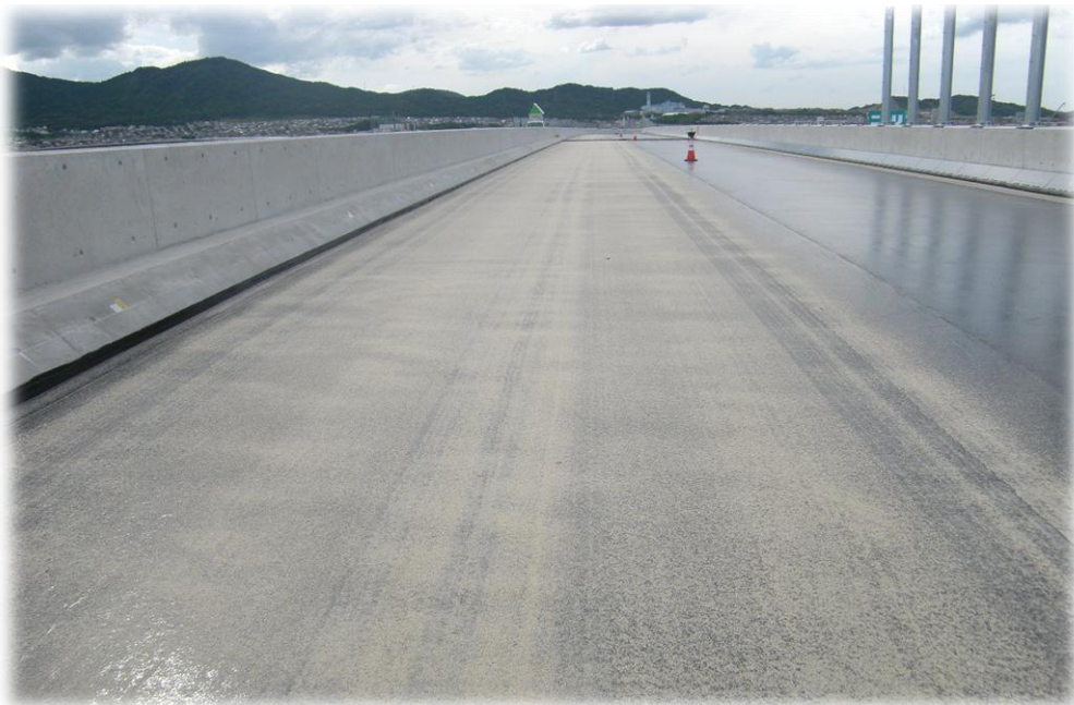
福岡都市高速道路 珪砂(4号サイズ) 散布完了
